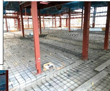
床暖房の配線工事!すごい!
