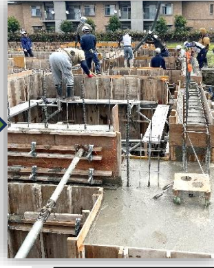
基礎にしっかり鉄筋とコンクリートが打たれ、いよいよ柱の立ち上げと、屋根の工事開始です!
